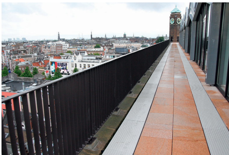
De Yellow Stone-tegels op de terrassen, waaronder de omloop op het pand, zijn geplaatst op tegeldragers.
