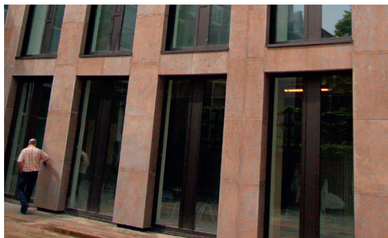
De buitengevels zijn bekleed met onder meer 500 m 2 Kirchheimer Muschelkalk in platen van 40 mm dik. "Het is een prachtige gemêleerde steen." (Foto: Benetti Marmi Nederland)
